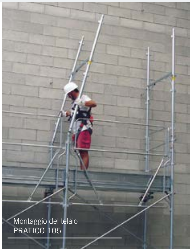
Montaggio del telaietto di parapetto
